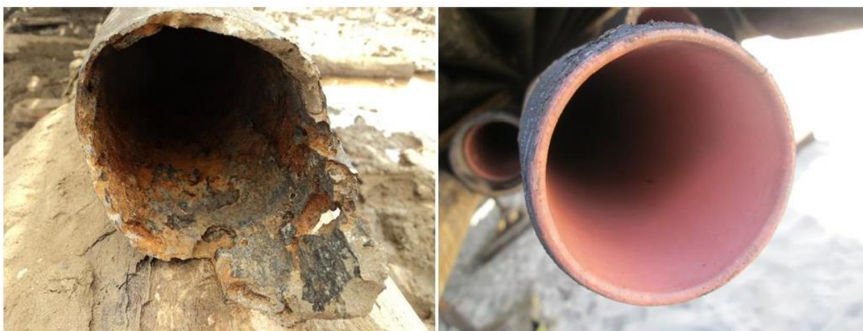
Рисунок 3.6 - НКТ до использования защитных покрытий и НКТ после гуммирования
