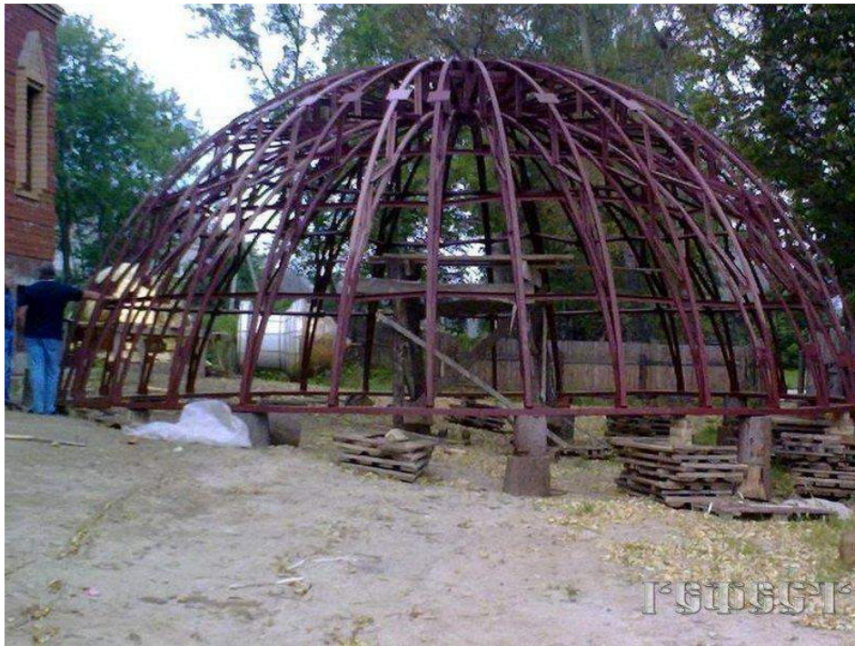
Рис.4.В Конструкция каркаса из металлических ферм купола
