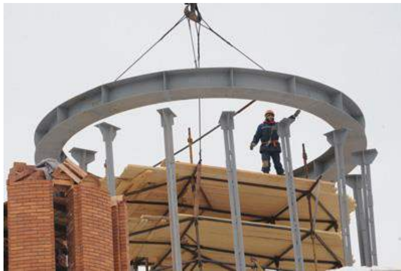
Рис.5.В Пример установки распорного кольца на колонны
