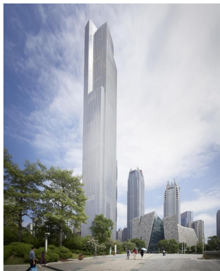
Рисунок 10 – Комплекс «Guangzhou CTF Finance Centre»
