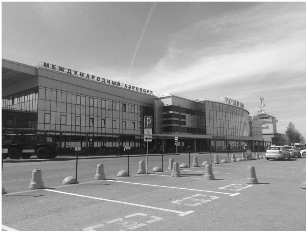
Рис.2 – Вид на современный терминал аэропорта
