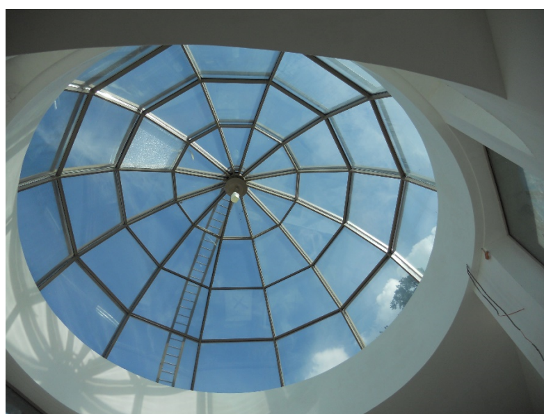
Рис.7 Алюминиевые конструкции остекления купола
