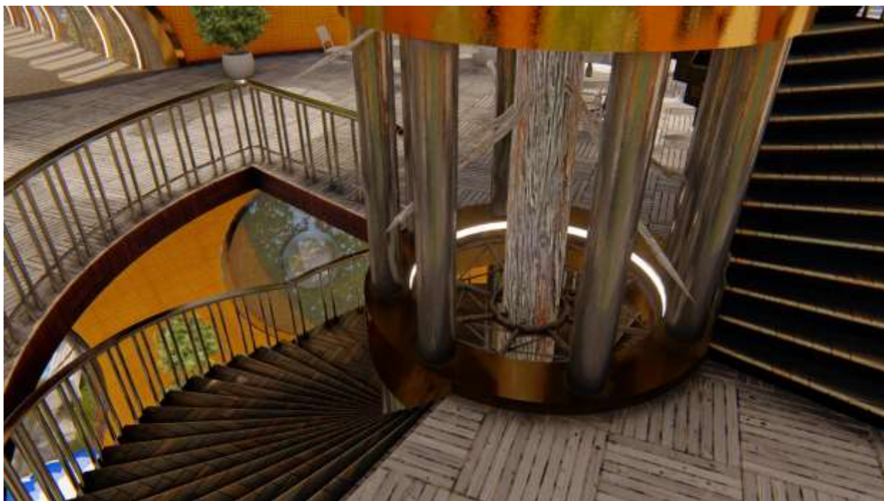
Рис. № 45 Опорное кольцо и несущие столбы.
