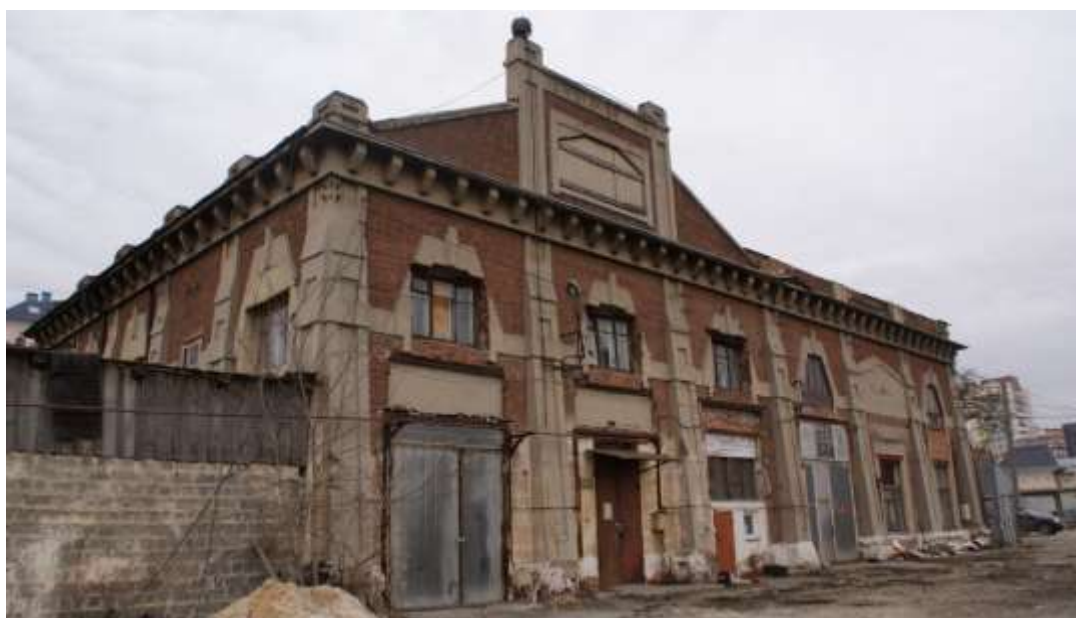
Рис. № 3 Вид на электростанцию с территории участка по ул. Труда 86
