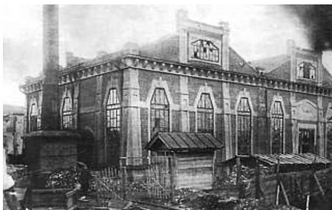
Рис. № 5 Электростанция, в послереволюционный период [16]
