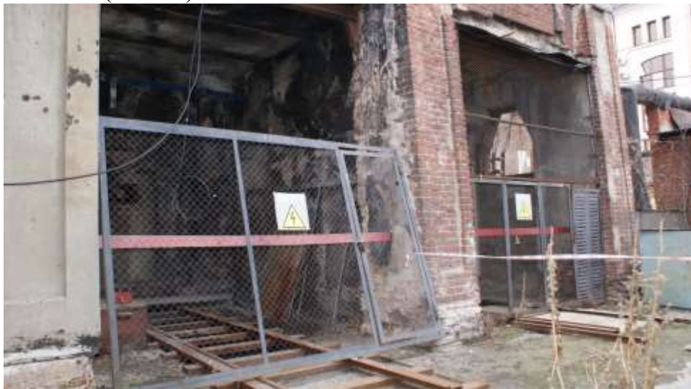
Рис. № 6 Остатки тяговой подстанции
