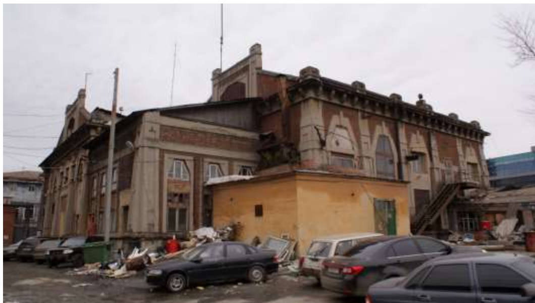
Рис. № 2 Вид на электростанцию со стороны набережной
