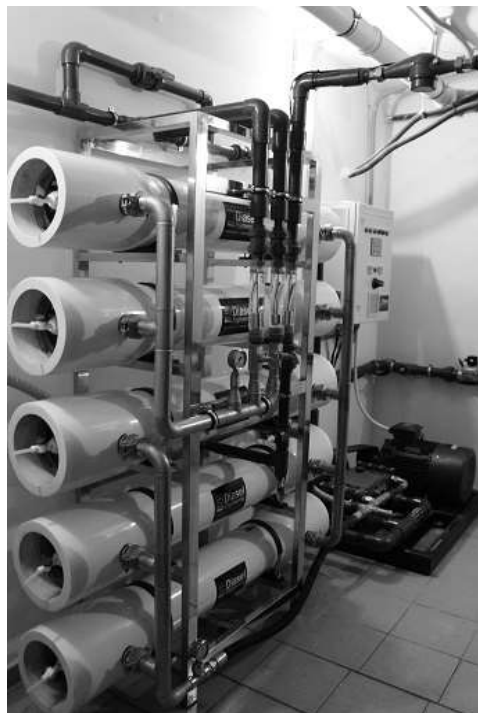
Рисунок 24 – Установка обратного осмоса DRO-8040-5
