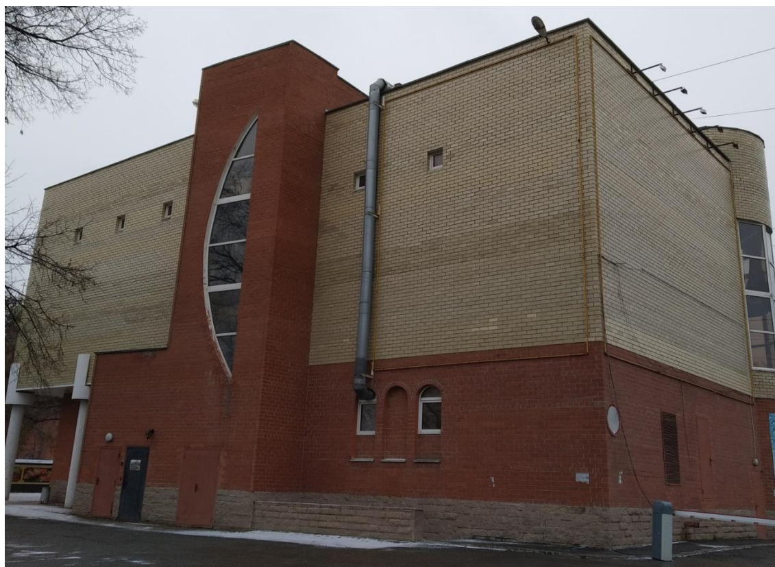
Рис. 2.2 Здание в сквере
