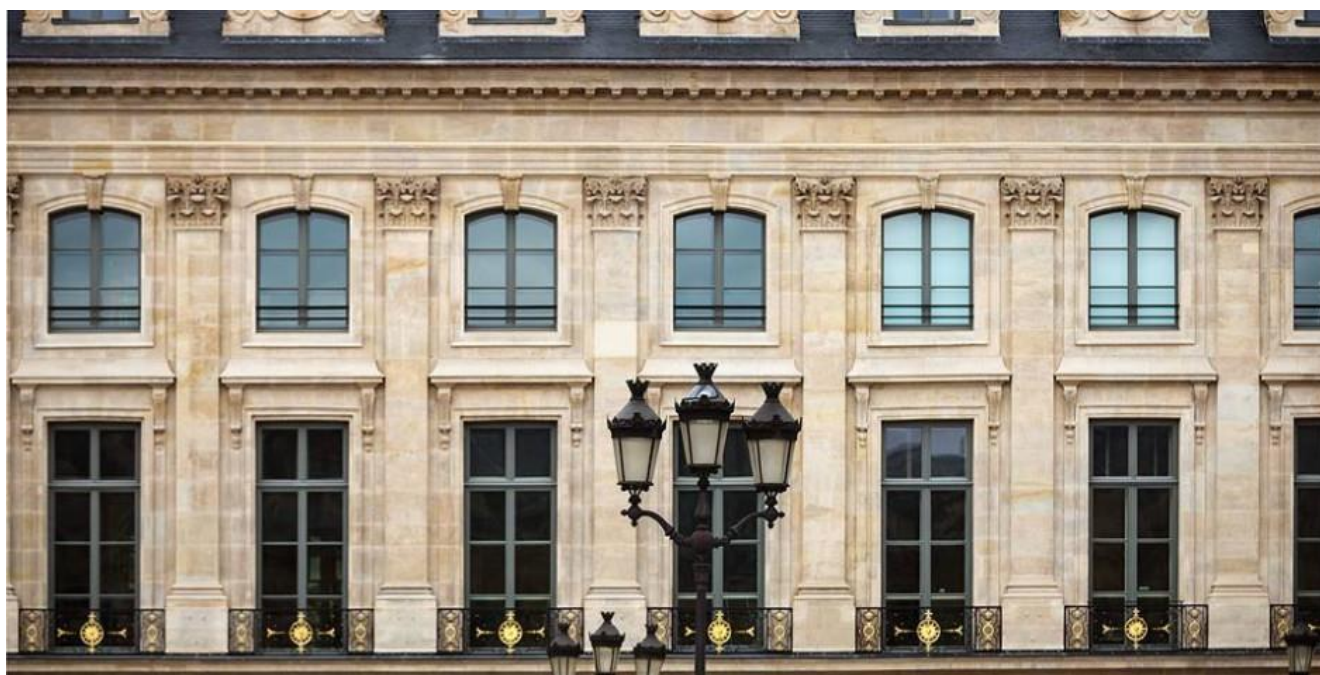
Рисунок 1.6 Фасад гостиницы после реконструкции
