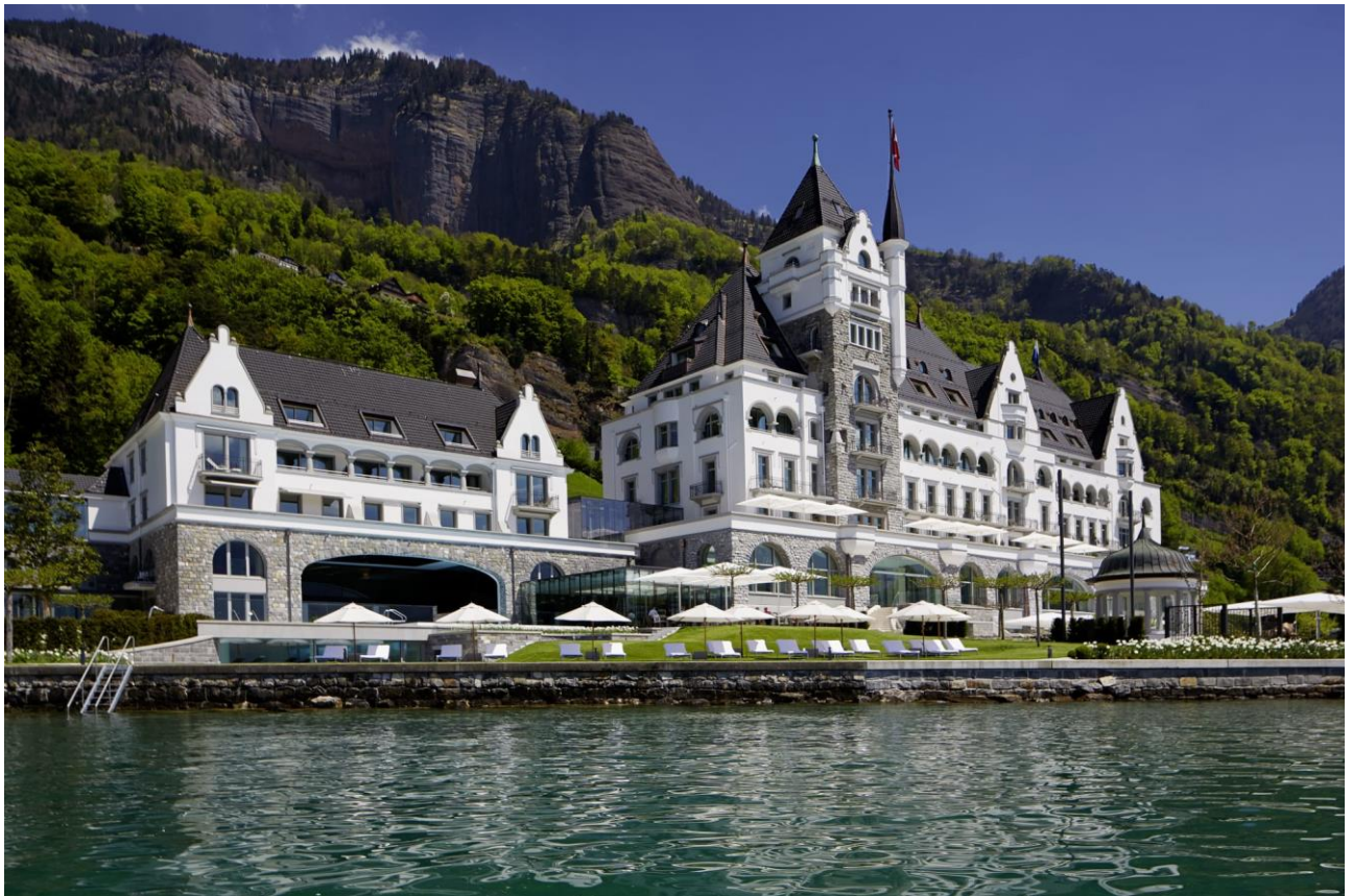
Рисунок 1.8 «Park Hotel Vitznau» после реконструкции
