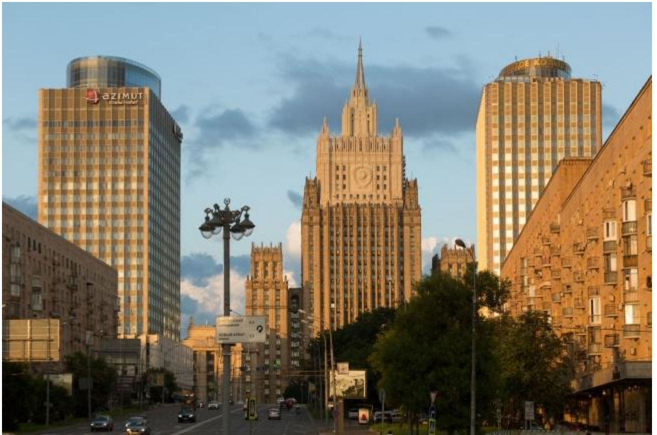
Рисунок 1.2 Вид архитектурного ансамбля после реконструкции
