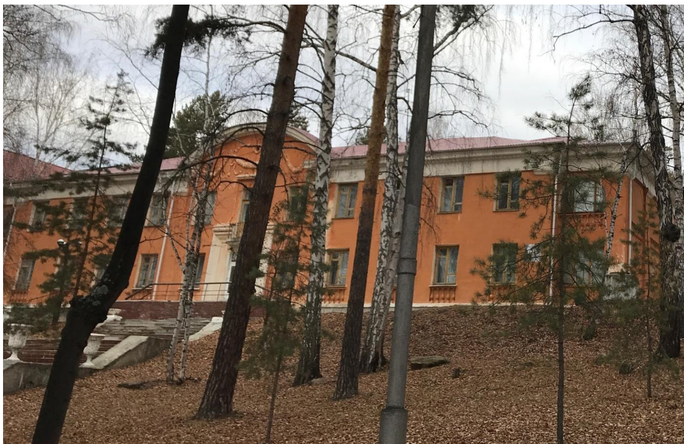
Рисунок 1 Фасад здания до реконструкции
