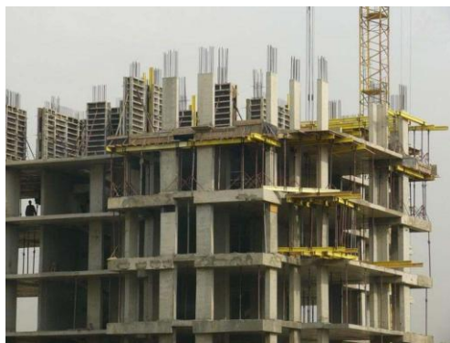
Рис. 1.1. Возведение каркасно-монолитного здания с помощью щитовой опалубки.
