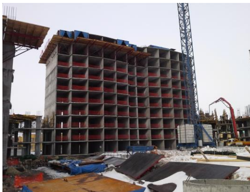
Рис. 1.2. Многоэтажный жилой дом, возводимый с использованием тоннельной опалубки.
