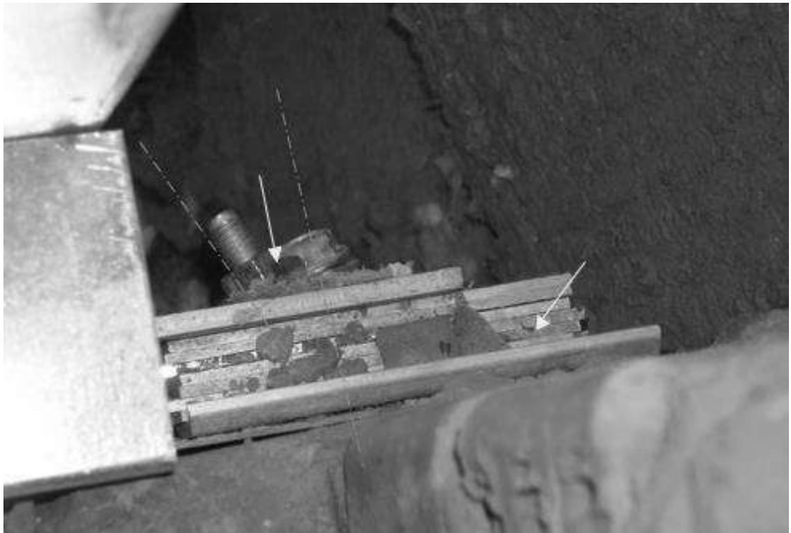
Рисунок Д.6 Неперпендикулярность установки анкеров
