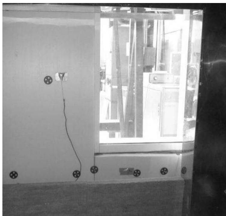
Рисунок 3.1.2.2 Исследуемый фрагмент с утеплением 50 мм без дефектов
