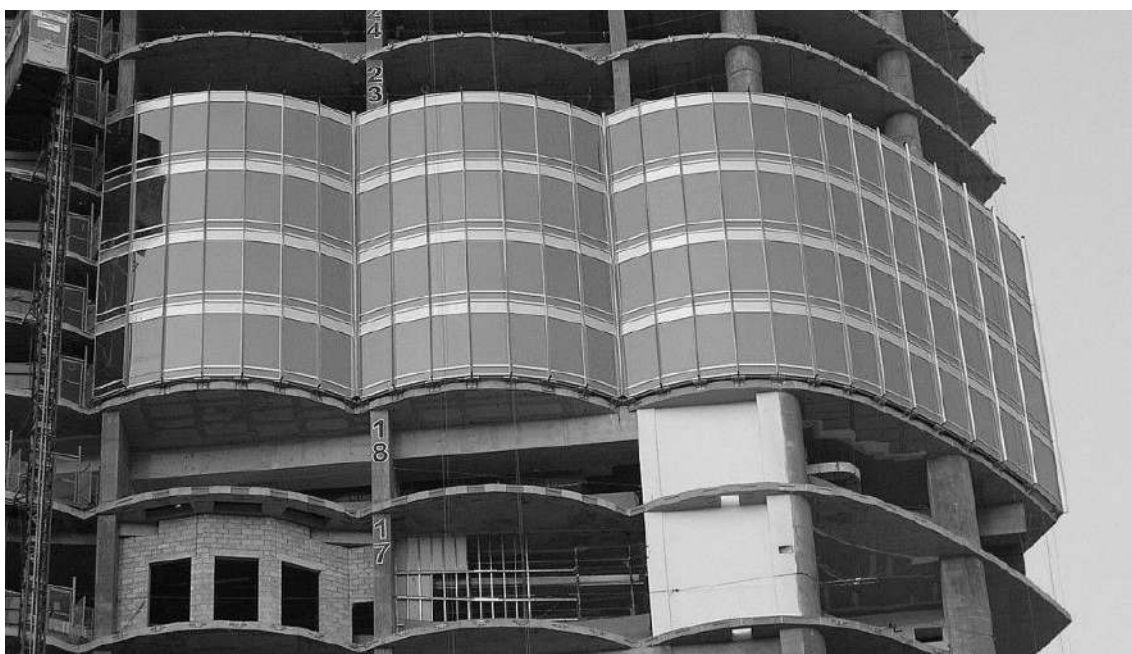
Рисунок Б.6 Модульное витражное остекление фасада
