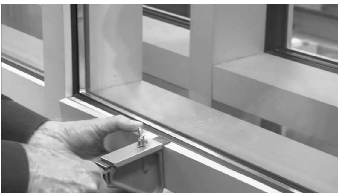
Рисунок А.2 Снятие декоративных алюминиевых крышек
