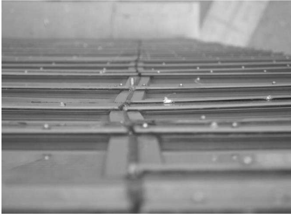
Рисунок Д.9 Штабелирование и несоосность
