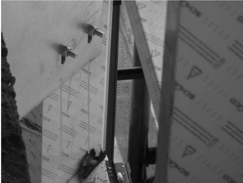
Рисунок Д.7 Болты в верхней части овальных отверстий. Не обеспечена возможность перемещения стойки по направлению вверх.
