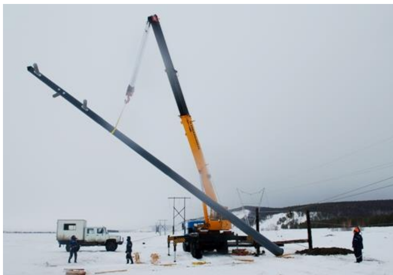
Рис. 1.9. Установка стеклопластиковой опоры.
