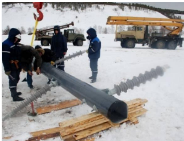
Рис. 1.8. Монтаж траверсы
