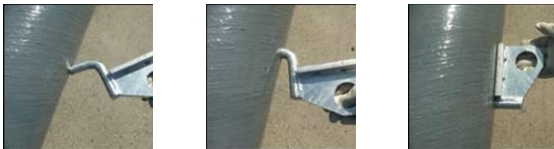
Рис. 1.3. Установка зажимов
