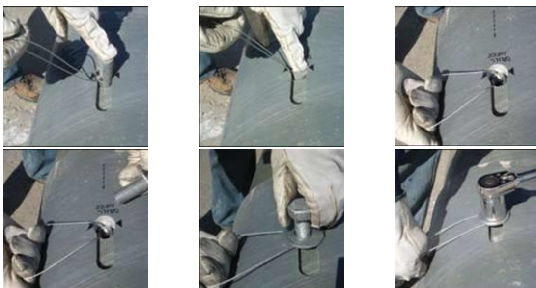
Рис. 1.6. Установка болтового соединения
