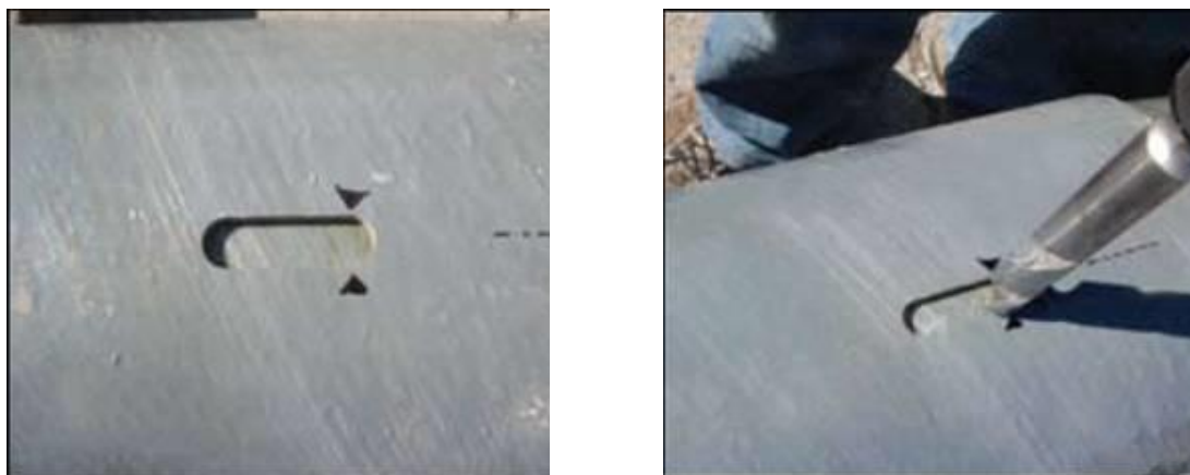
Рис. 1.5. Отверстие под болтовое крепление секции
