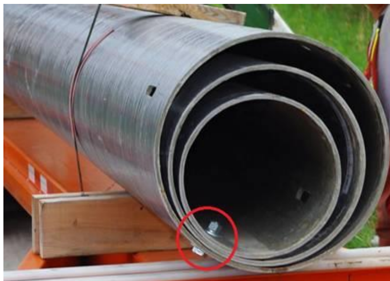
Рис. 1.1. Транспортировка секций для опоры ЛЭП
