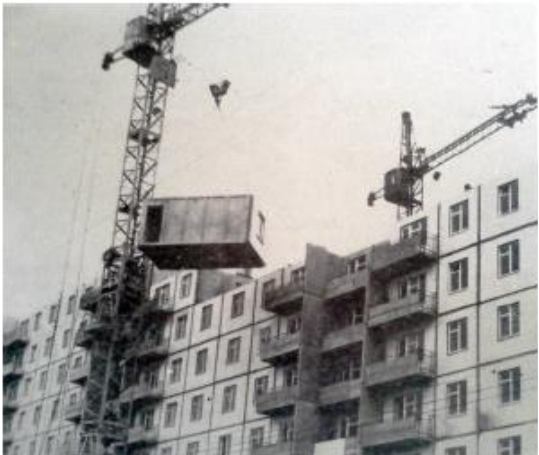
Рисунок 1 – Установка объемных блоков
