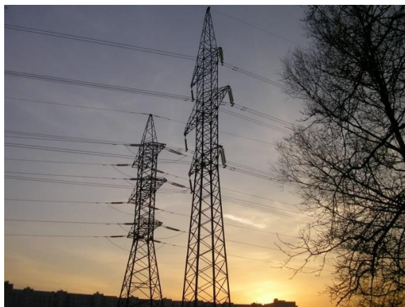
Рисунок 19 – АМС в исполнении «Опора ЛЭП»
