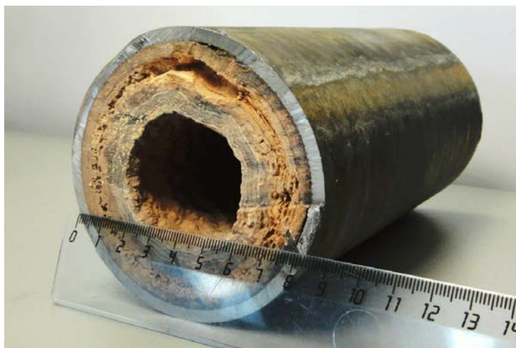
Рисунок 1.1 – Отложения на стенках трубы
