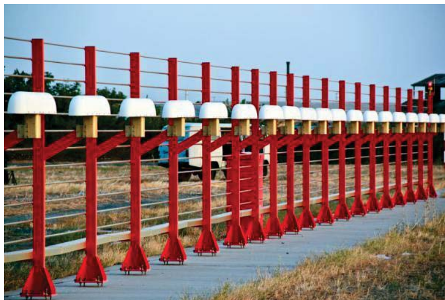
Рисунок 2 – Антенна курсового радиомаяка системы посадки Thales ILS-410
