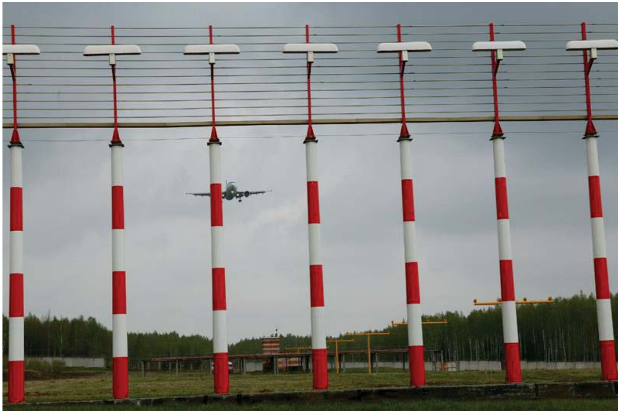
Рисунок 3 – Антенна курсового радиомаяка системы посадки Thales ILS-410
