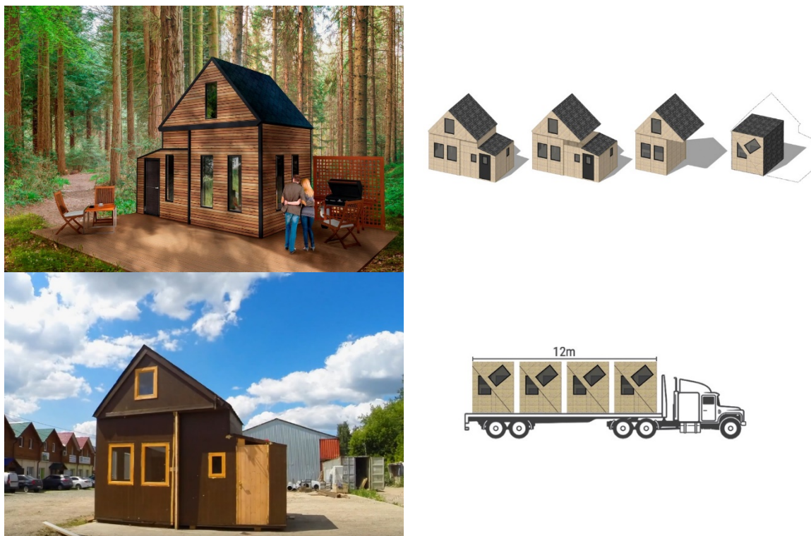
Рис. 5. Сборный дом Brette haus из многослойных деревянных панелей «Древоблок»
