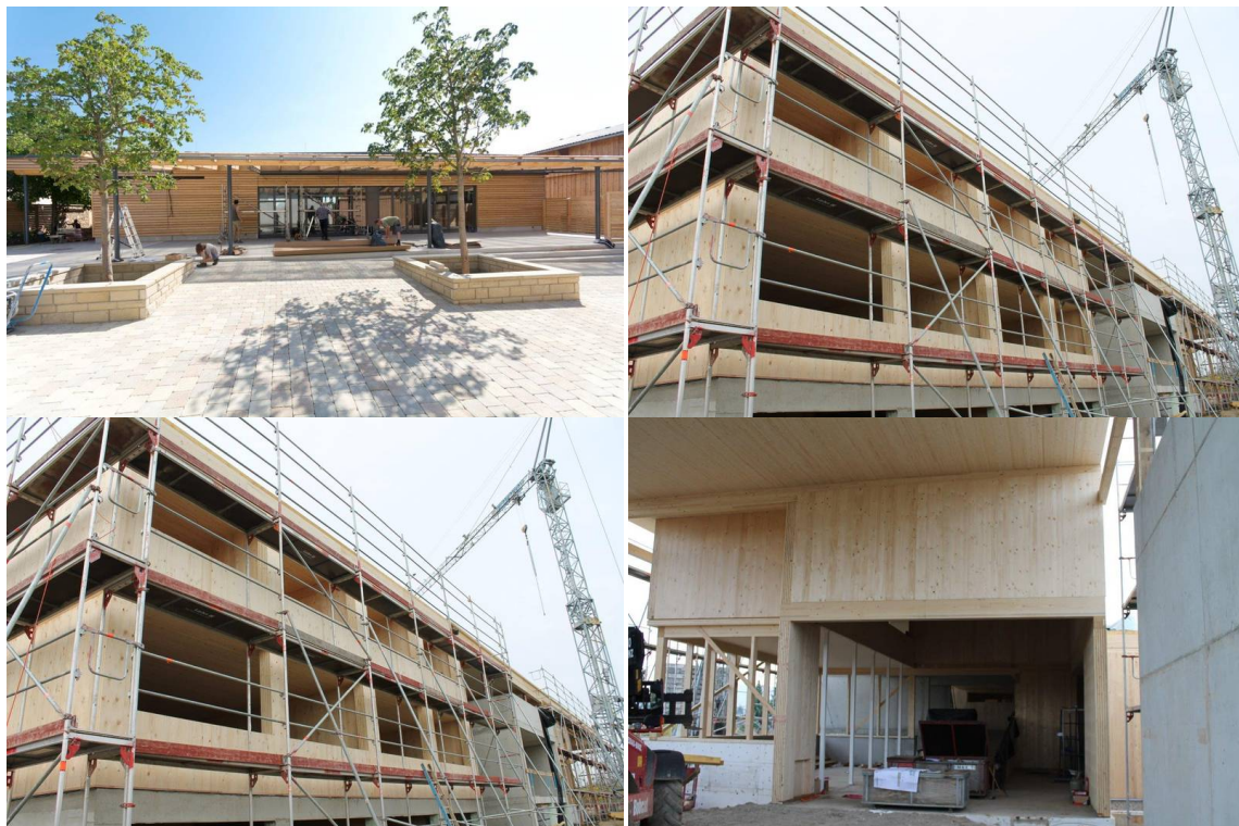
Рис. 2. Винодельческий завод. Йоханеса Б., возведенный по технологии Massiv-Holz-Mauer, арх. Dengler Katzenwald Zischler Architekten, Фелльбах
