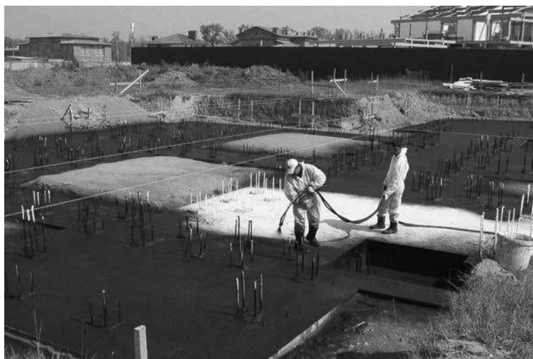
Рисунок 8 – Покрытие жидкой резиной фундамента здания
