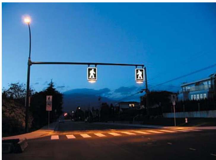
Рисунок 3.5 – Дополнительная подсветка дорожных знаков и пешеходных переходов
