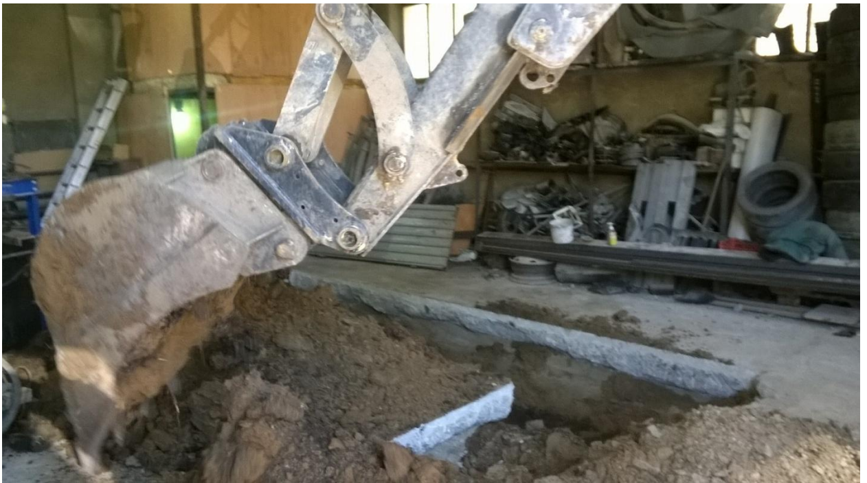
Рисунок 10 – Выборка грунта
