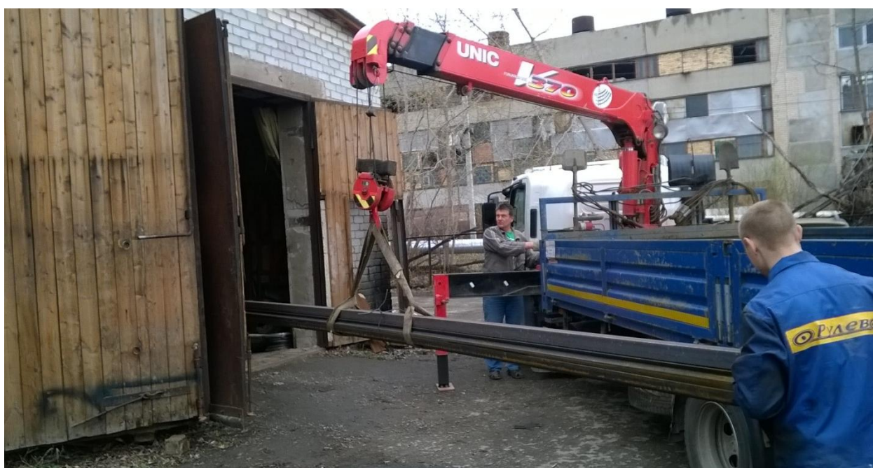
Рисунок 7 – Завоз строительных материалов
