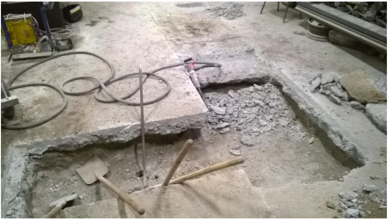
Рисунок 9 – Вскрытие бетонного покрытия
