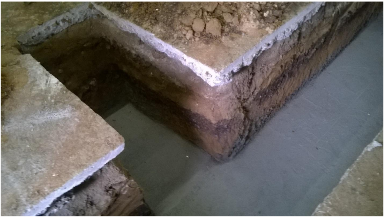
Рисунок 11 – Заливка бетонной стяжки пола
