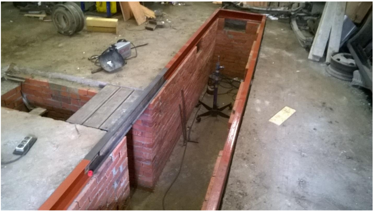
Рисунок 13 – Изготовление и монтаж арматурной оснастки
