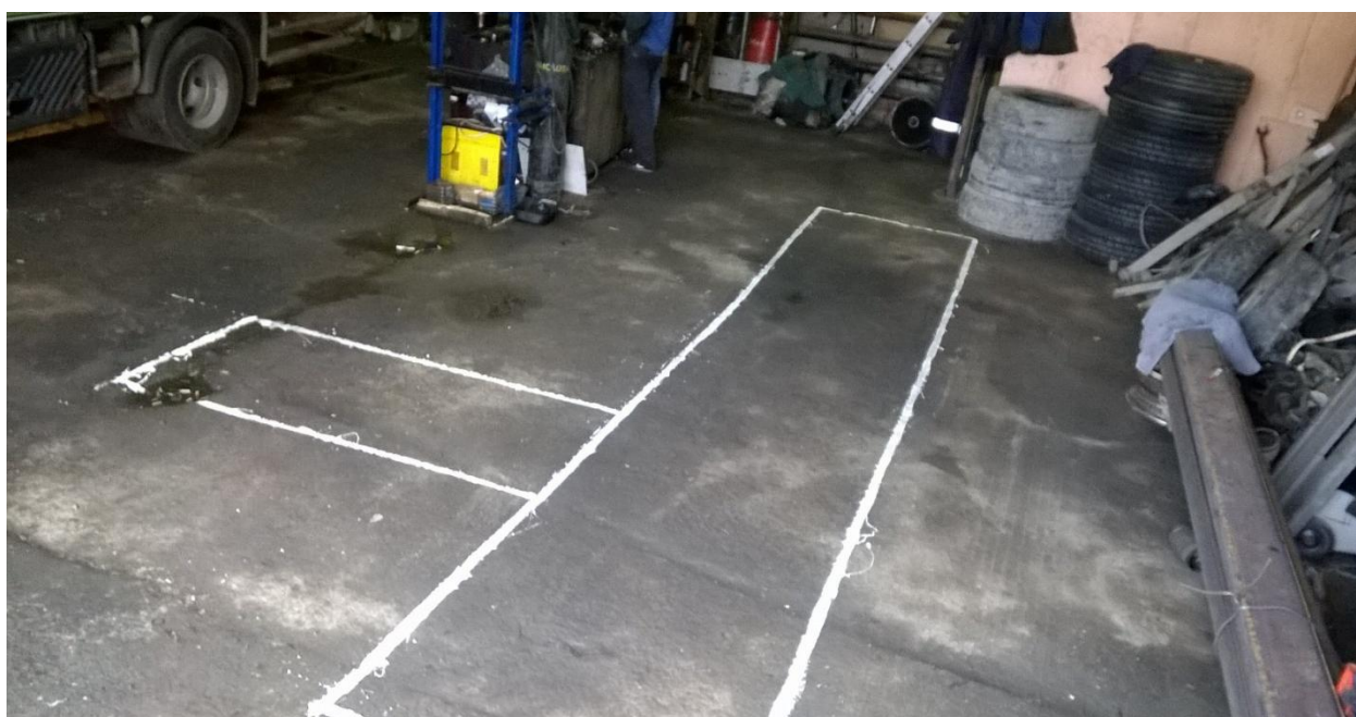
Рисунок 8 – Разметка осмотровой канавы
