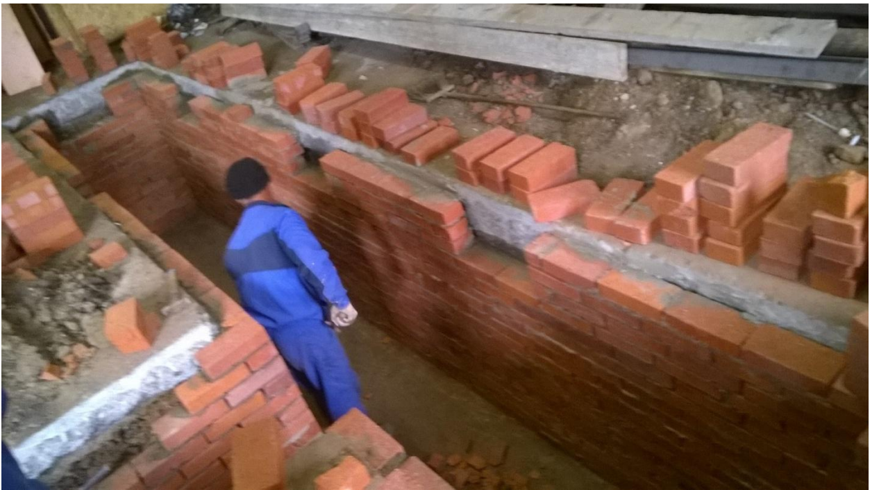
Рисунок 12 – Возведение стен с нишами под святильники
