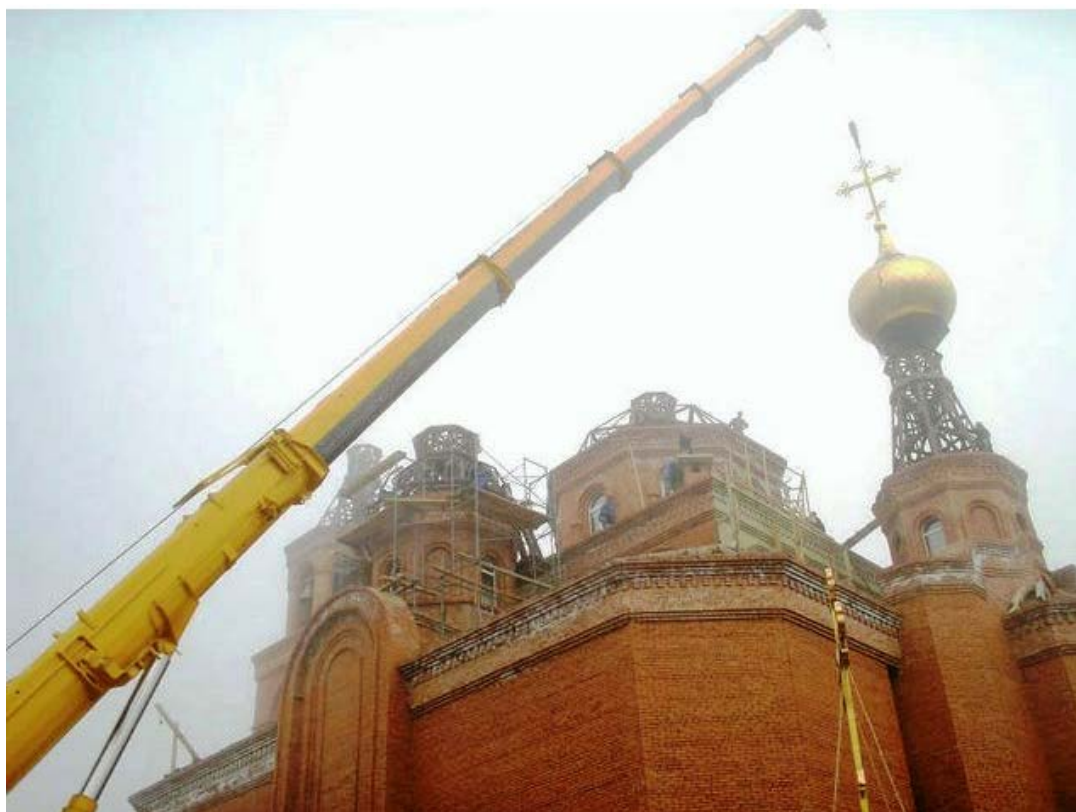
Рисунок 1.1 – Монтаж куполов Челябинского органного зала
