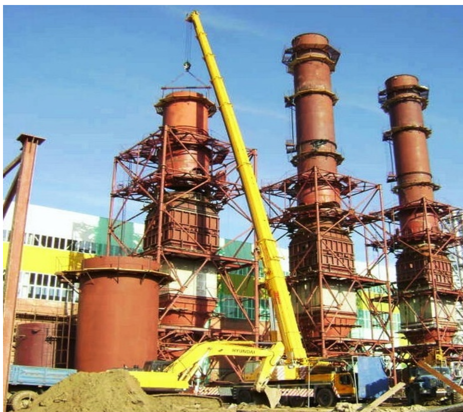
Рисунок 1.2 – Монтаж оборудования при строительстве Приобской ГТЭС
