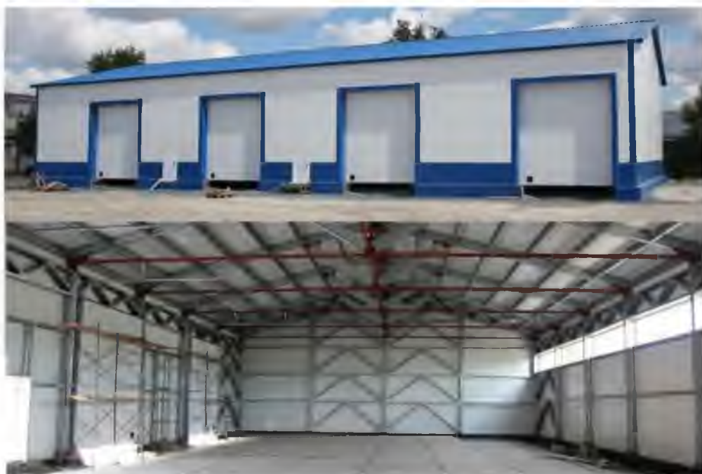
Рисунок 9 – Проект быстровозводимого здания СТО
