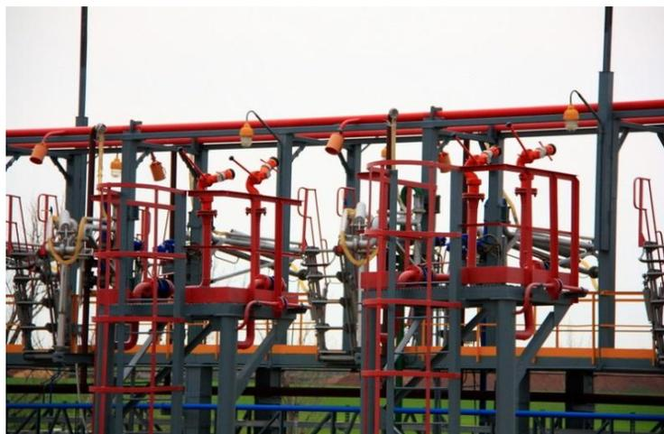
Рисунок 6 – Мониторы подачи низкократной пены на каждую железнодорожную цистерну грузоподъемностью 140 м<sup>3</sup>
