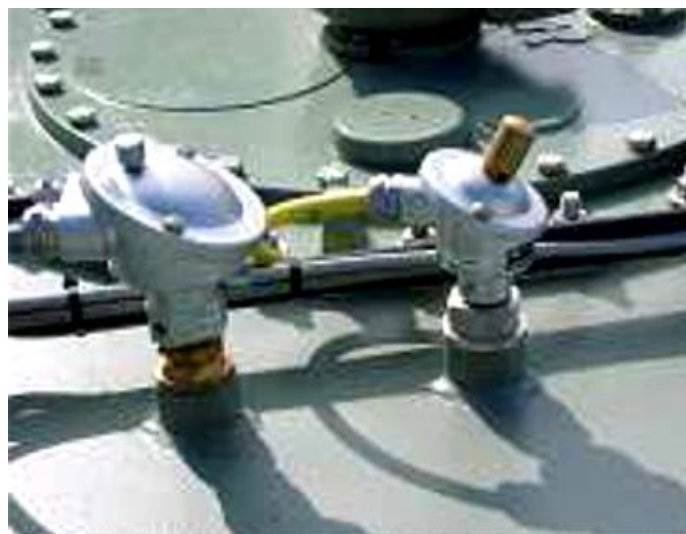
Рисунок 1.1 – Температурный датчик для измерения масла в баке
