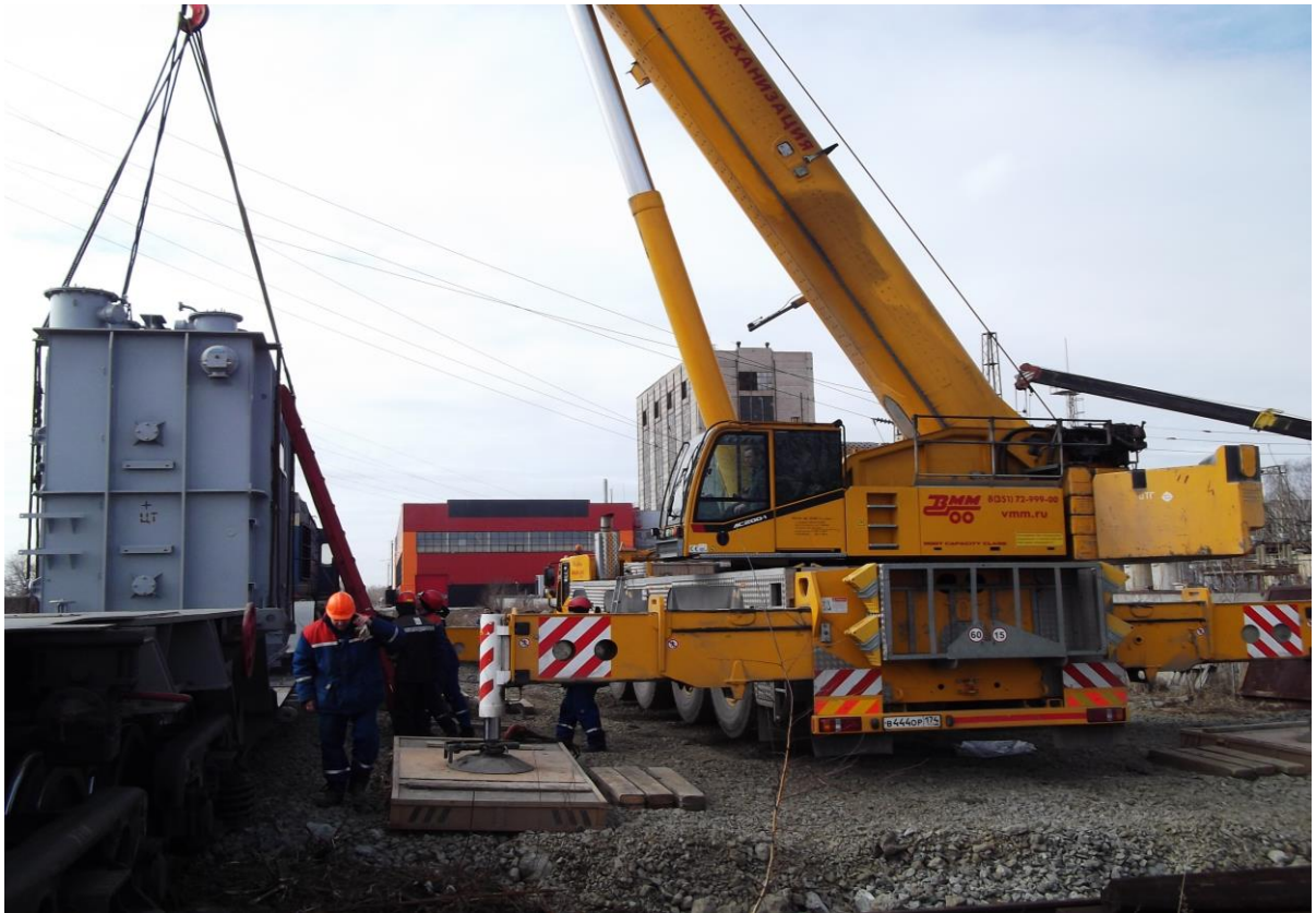
Рисунок 1 – Разгрузка трансформатора типа ТДТН-40000/110/35/6
