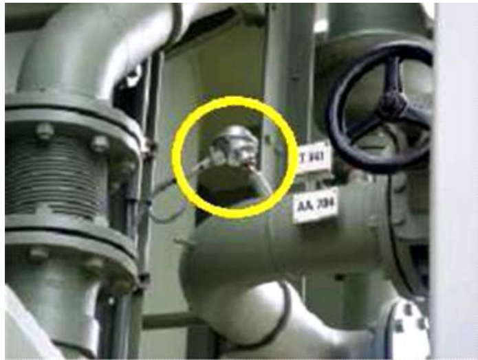
Рисунок 1.2 – Температурный датчик для измерения масла в системе охлаждения 3 Датчик температуры окружающей среды. Используется резисторный термометр Pt100 с 3-проводным соединением (рис. 1.3).
