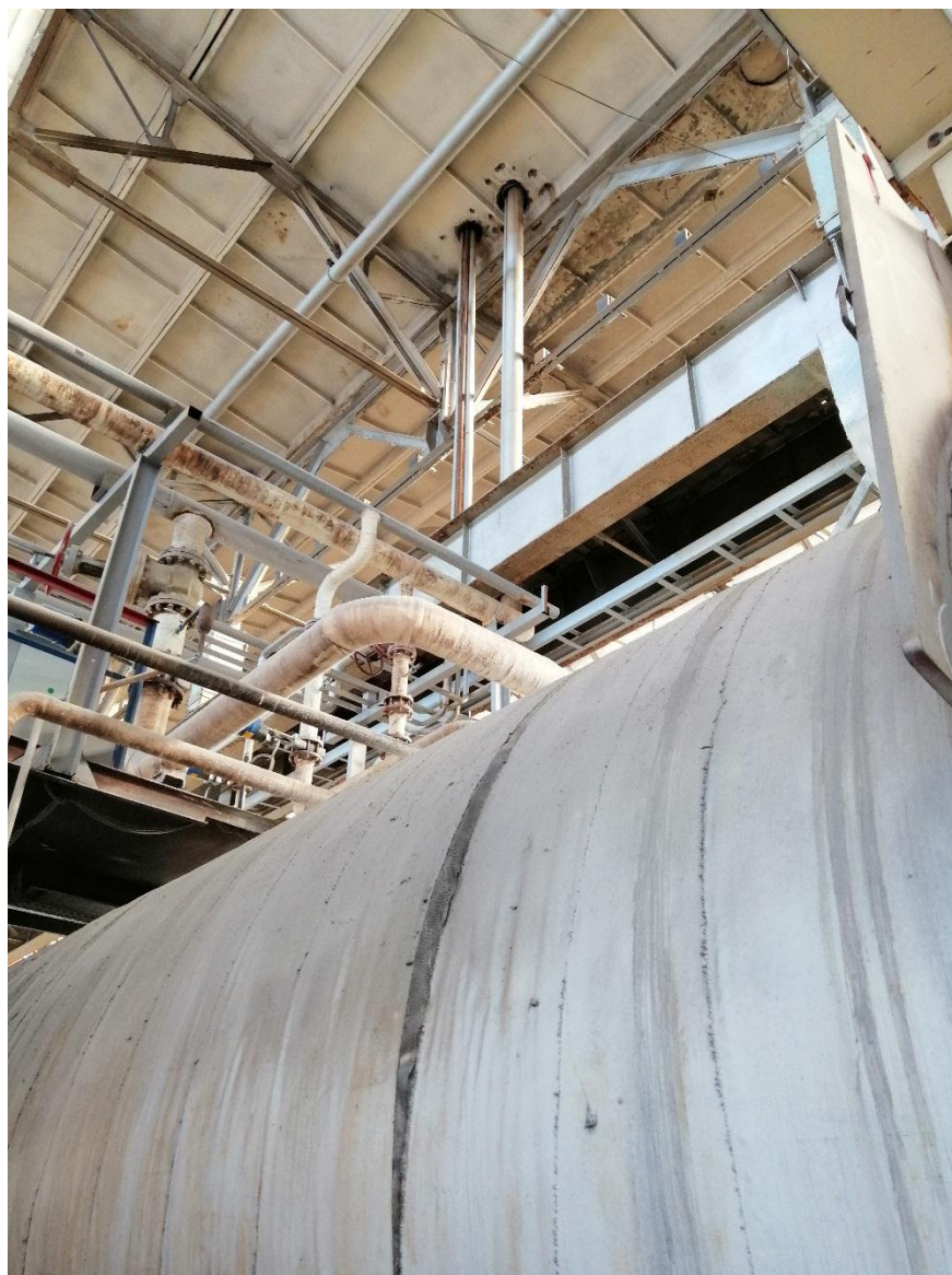
Рисунок 1П – Труба для сброса пара
