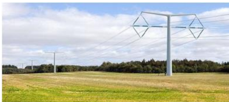
Рисунок 18 – Линия 110 кВ с применением композитных опор
