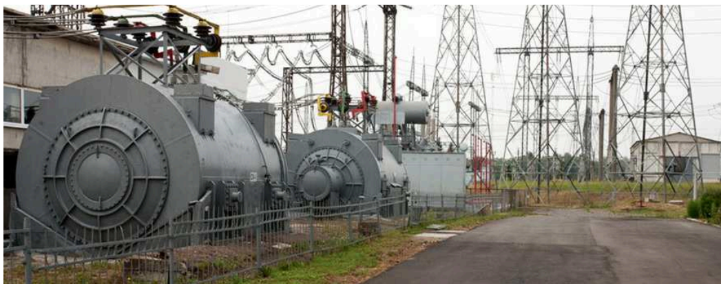
Рисунок 27 – Размещение синхронного компенсатора на подстанции
