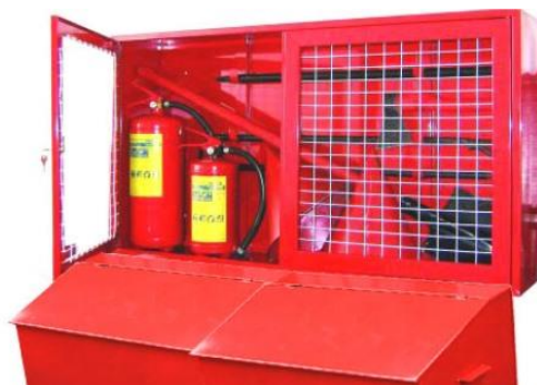
Рисунок 8.2 – Исполнение ЩП-Е закрытого типа
