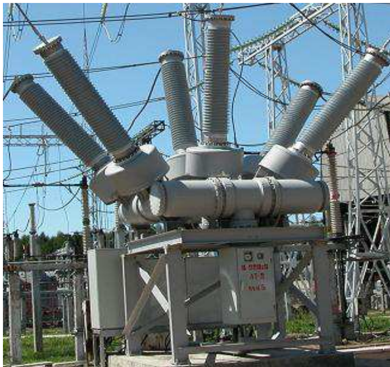
Рисунок 23 - Элегазовый выключатель ВГБУ-110У-1
