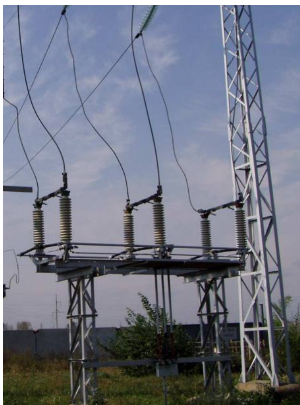
Рисунок 24 - Разъединитель РДЗ-110/1000У1
