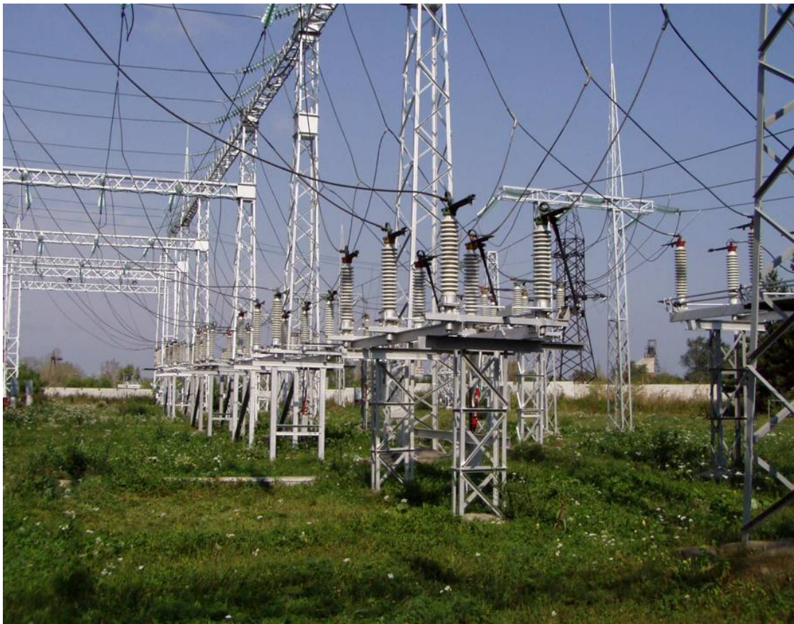
Рисунок 16 – Разъединители РДЗ-110
