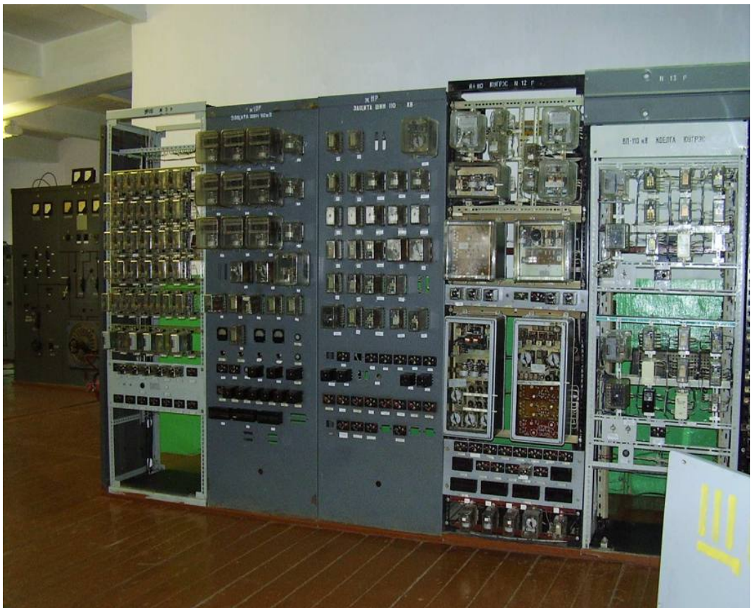
Рисунок 18 – ОПУ, комплекты защит ВЛ-110 кВ
