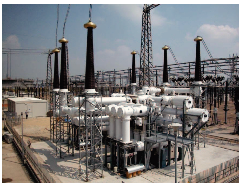
Рисунок 3.2 – КРУЭ наружной установки.
