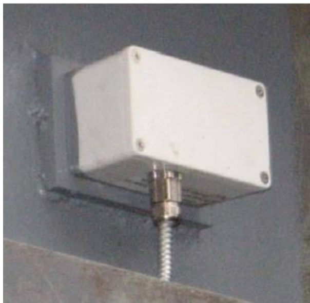
Рисунок 3.7 – Способ крепления на баке трансформатора датчиков ЧР AC-Sensor
