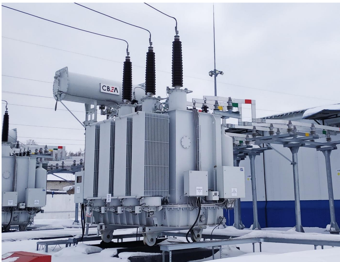
Рисунок 3.2 – Трансформатор ТРДН-25000/110/6
