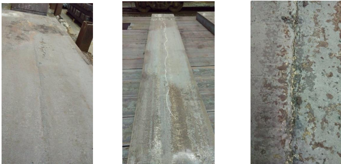
Рисунок 2.4 – Внешний вид НЛС с размерами сечения 250x770 мм с наличием дефекта типа «кристаллизационная трещина»
