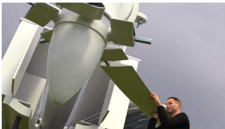
Рисунок 4.6 – Установка лопастей мобильной ветроустановки
