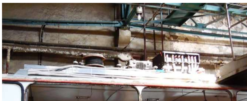
Рисунок 2.9 – Электрооборудование, расположенное на крыше троллейбуса
