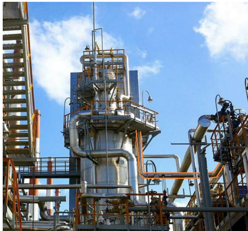
Рисунок 3.3- Вид установки НТК после реконструкции
