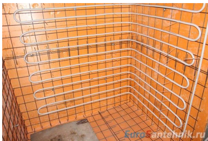
Рисунок 3.1 Система водяных теплых стен
