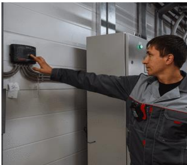
Рисунок 3.2 – Установка сигнализатора СТГ-1
