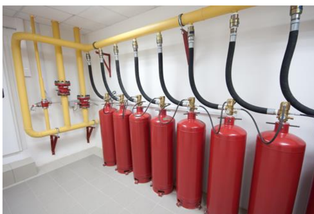
Рисунок 1.7 – Модули газовой АУПТ
