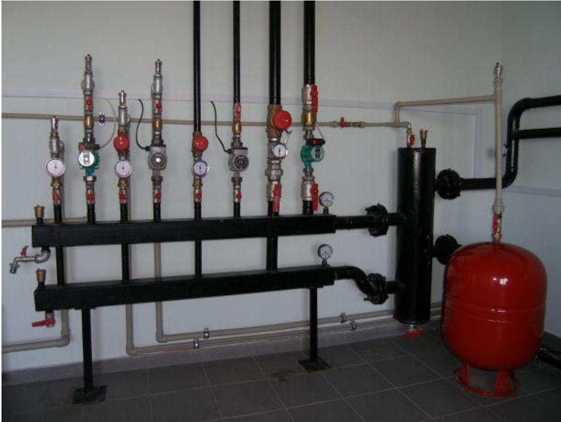
Рис. 1. Термогидравлический разделитель с гидроколлектором
