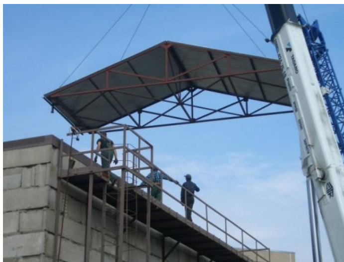
Установка предварительно собранной кровельной конструкции
