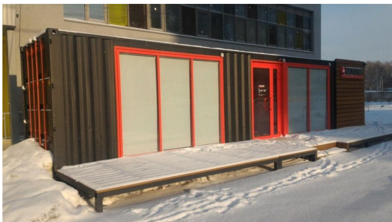
Рис. 6. Контейнер-офис. Челябинск. Источник: фото автора
