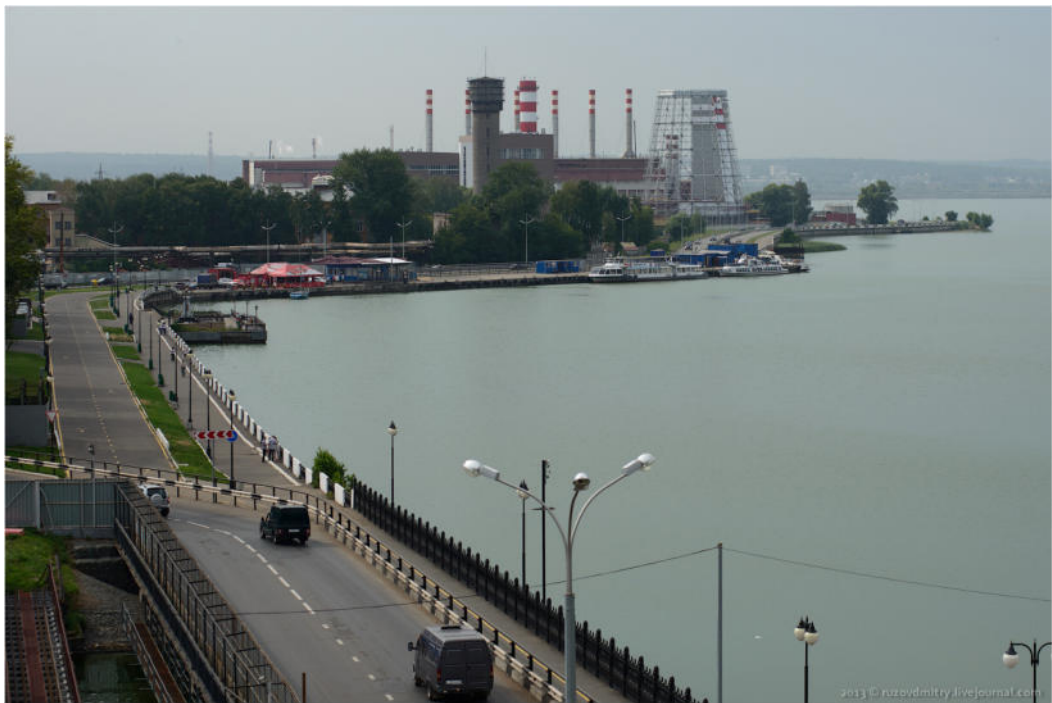
Рис. 4. Промышленная набережная. Набережная Южная, Ижевск, респ. Удмуртия
