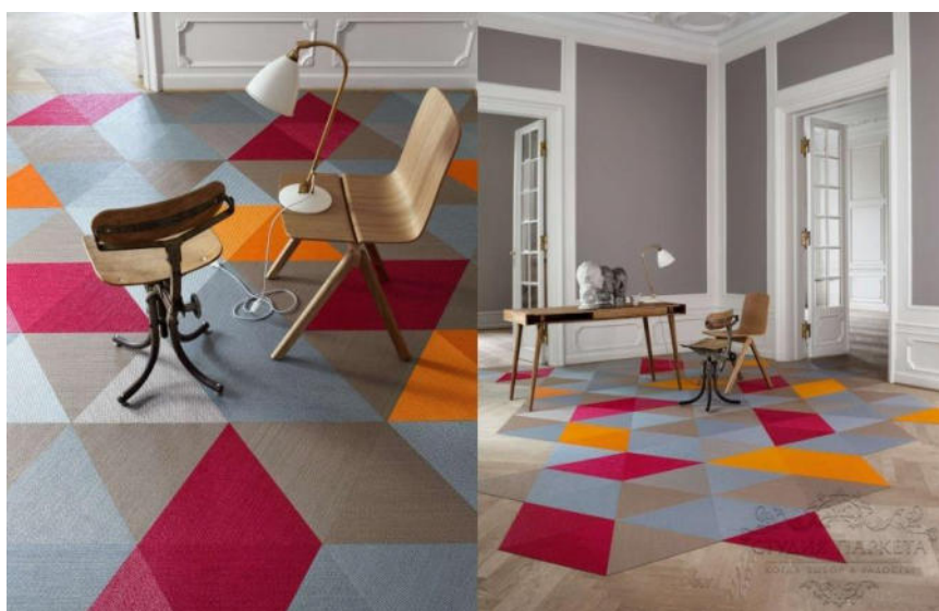
Рис. 3.12. Отделка полов виниловой плиткой
