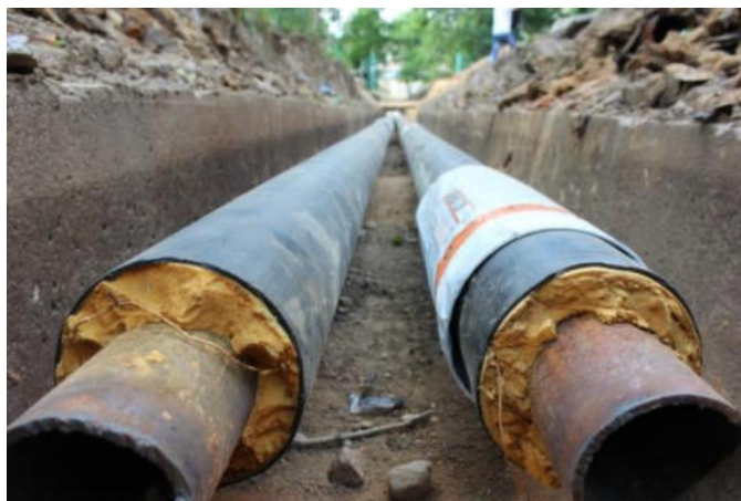
Рис. 4.5. Трубы теплотрасс
