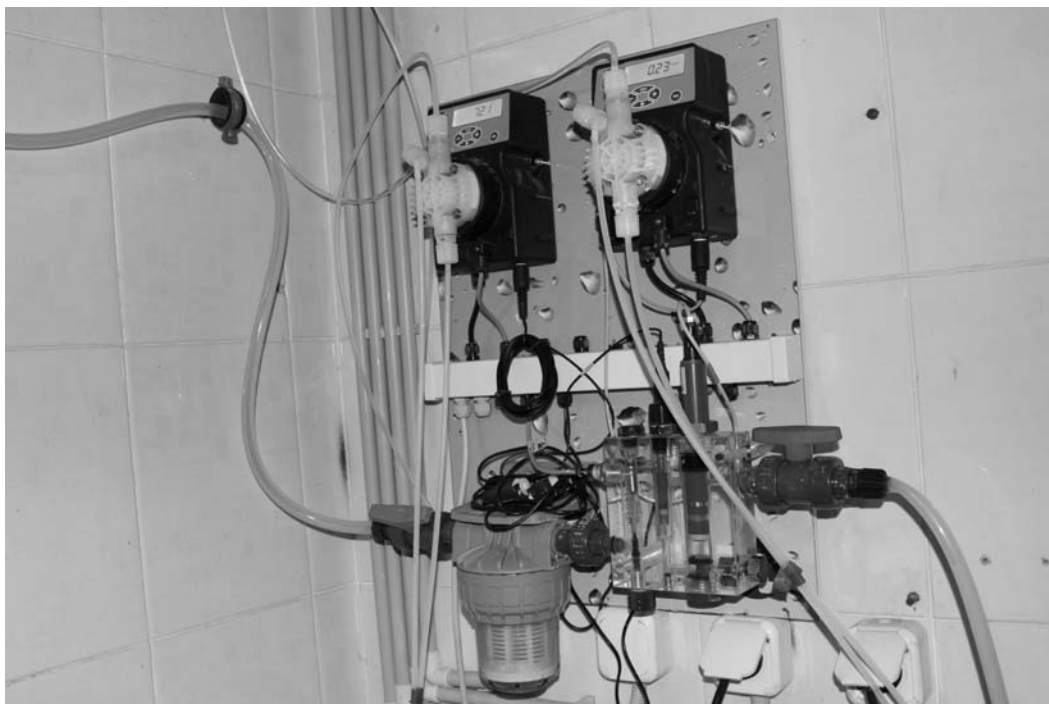
Рисунок 4.1.9 – Автоматическая система Etatron Pool Guard 7 (pH/Cl)
