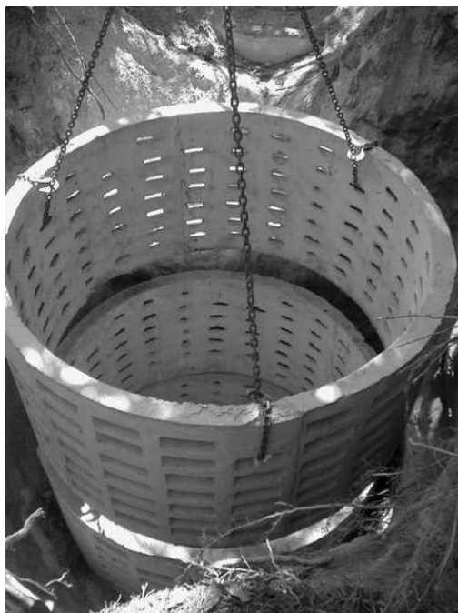
Рисунок 2.10 - Бетонный фильтрующий колодец
