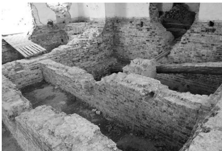
Рисунок 3.7 – Разница между высотами подошв фундаментов
