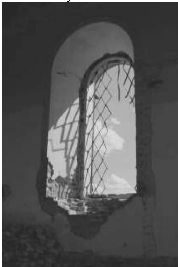
Фото 21. Отсутствие/разрушение штукатурного слоя, разрушение кладки подоконной части, разрушение оконной решетки, отсутствие оконного заполнения
