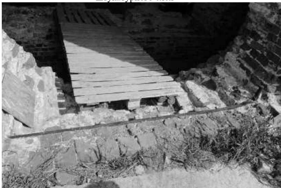
Фото 9. Отсутствие нижнего кирпича в южном дверном проходе в храм, растесанный проем, выветривание кирпича, высолы раствора, оголение стяжки
