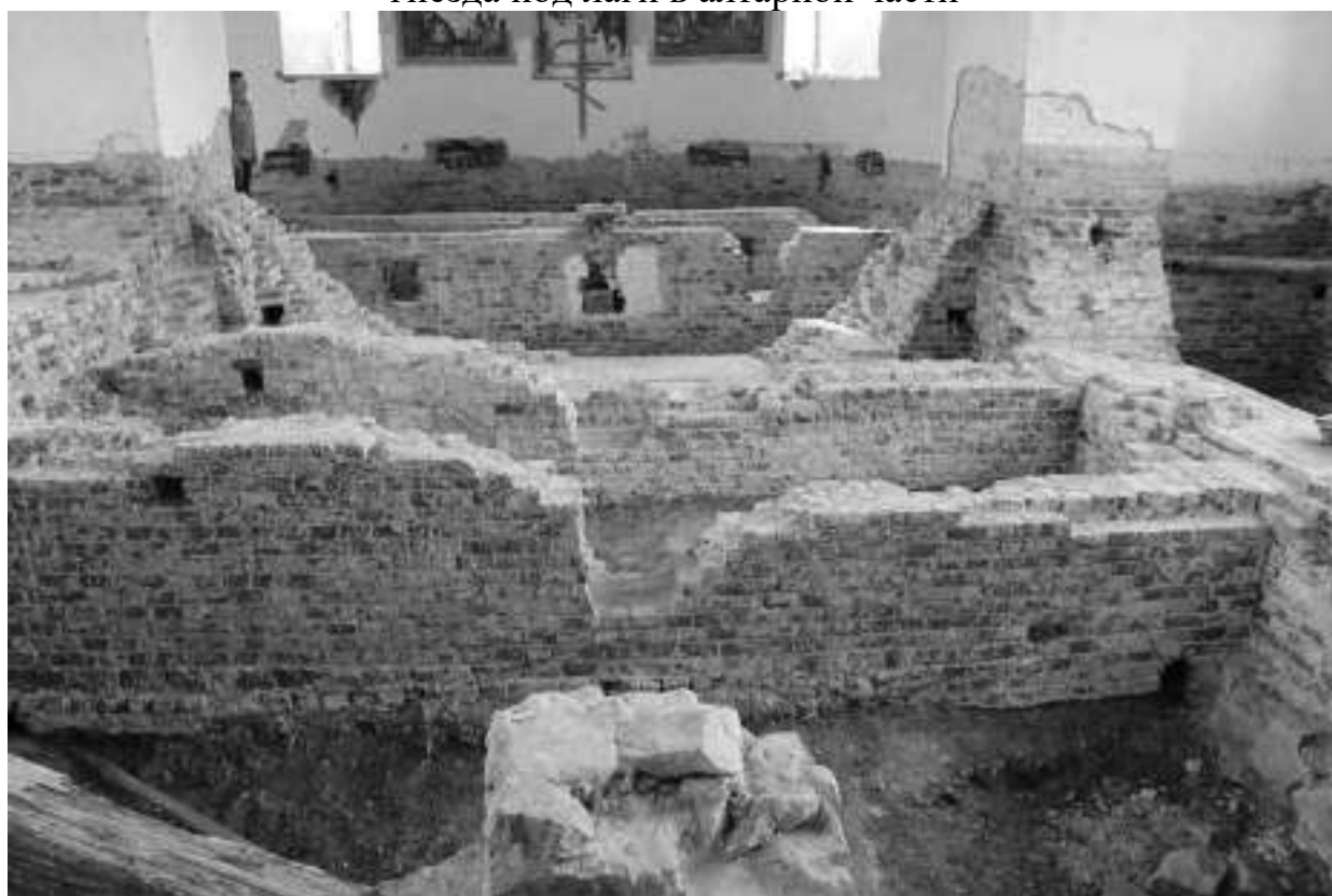
Фото 37. Отсутствие/разрушение штукатурного слоя, высолы раствора, локальное разрушение кирпичной кладки фундамента храма, частичное разрушение бутового фундамента храма, отсутствие пола
