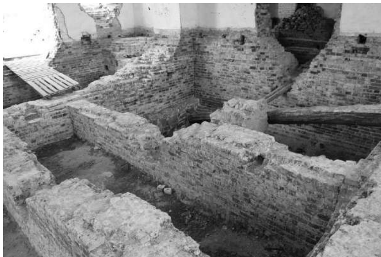
Рисунок 3.7 – Разница между высотами подошв фундаментов
