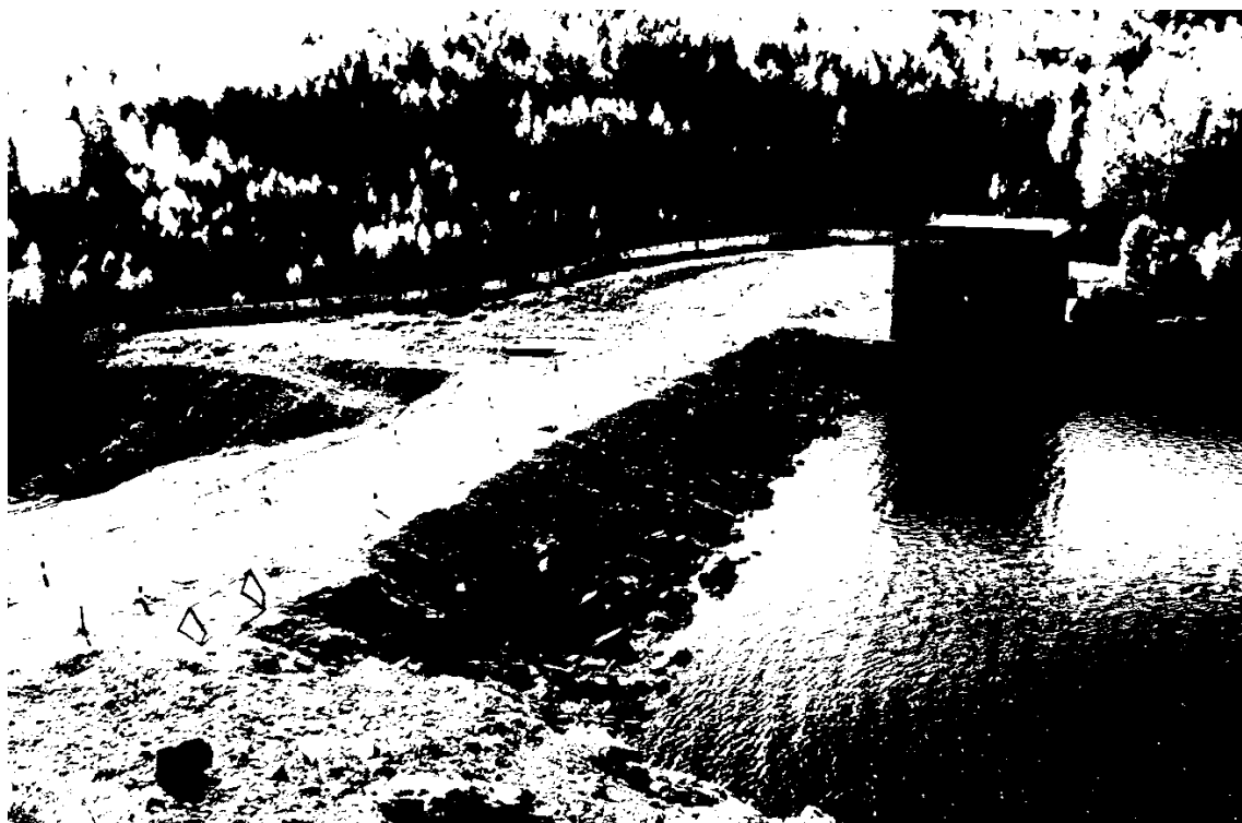
Рисунок 20 - Земляная плотина. Вид сверху.
