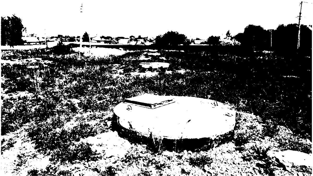
Рисунок 3 – Смотровые колодцы дренажного коллектора вид со стороны водоподпорного сооружения
