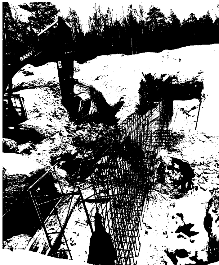
Рисунок 14 - Строительство водобойного колодца
