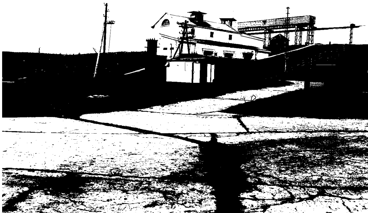
Рисунок 11 - Здание ГЭС. Вид с нижнего бьефа.
