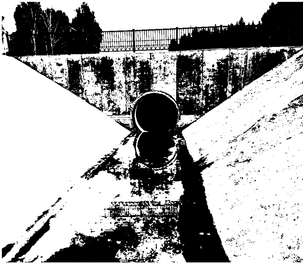
Рисунок 15 - Выходной оголовки и водобойный колодец
