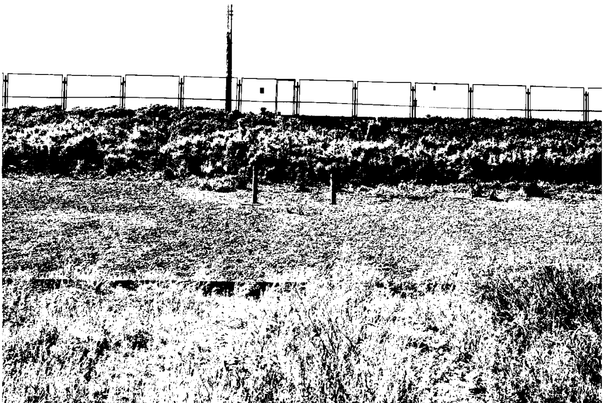
Рисунок 4 – Пьезометры, расположенные на низовом откосе водоподпорного сооружения
