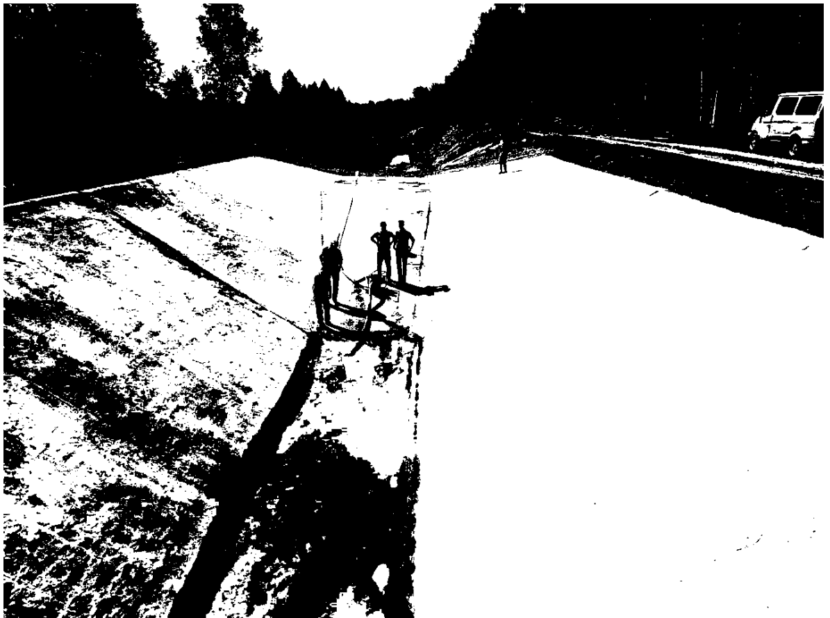
Рисунок 16 – Водобойный колодец
