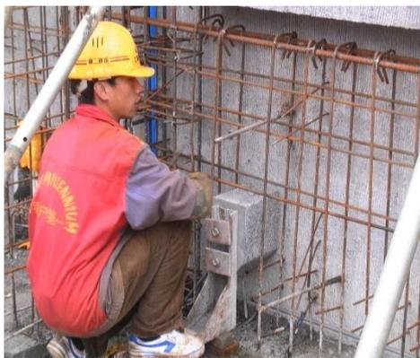
Разбивка Рисунок 5: Ножничные стены, опоры балок, возведение стоек для перекрытий и стеллажей для балконных перекрытий
