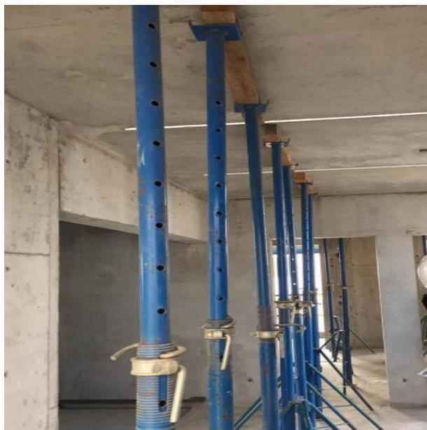
Не штабелируя части фанеры используя фанеру толщиной 15 мм, квадратный киль 50\*100 мм, расстояние 250 мм, фланцы стальной трубы используя Ф 48\*3.0 стальная полнотавровая рама в качестве опорной системы, расстояние между полюсами рамы такое же, как и между полюсами полнотавро-
