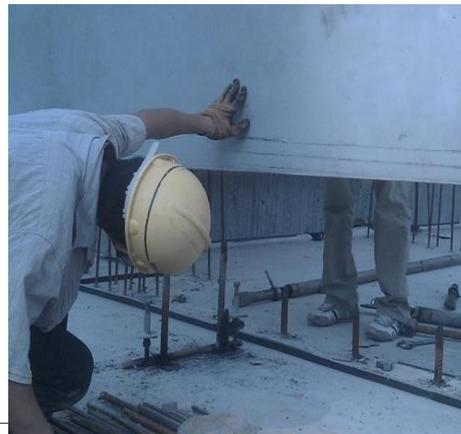
Стеновые панели и балконные перегородки поднимаются по часовой стрелке от первой. После установки первой плиты ПК и поднятия остальных блоков, готовые блоки могут быть откорректированы и привязаны арматурой.
