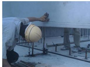
Перед подъемом проверьте и запишите длину резервированной арматуры, чтобы удостовериться, что длина арматуры, вытянутой в втулку, соответствует проектным требованиям. Устанавливаемый интерфейс целлюлозы должен быть очищен, а полив перед затиркой должен быть полностью увлажнен, но при этом не должно оставаться открытой воды. Компоненты должны собираться плавно и прочно и не должны нарушаться во время и после цементации в течение определенного периода времени.
