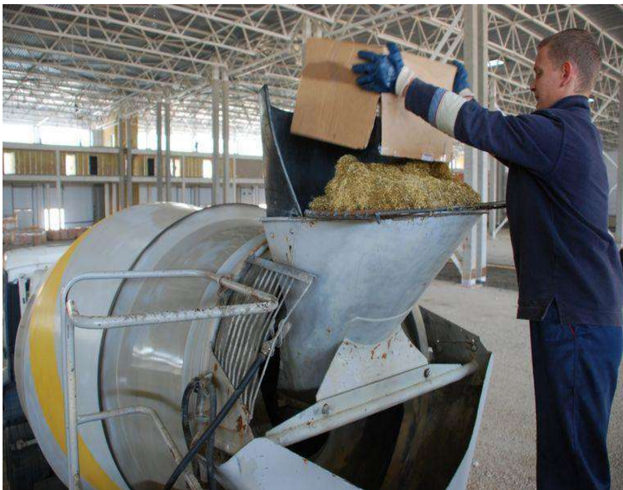
Рис. 1.2 Добавление волокна к бетонной смеси
