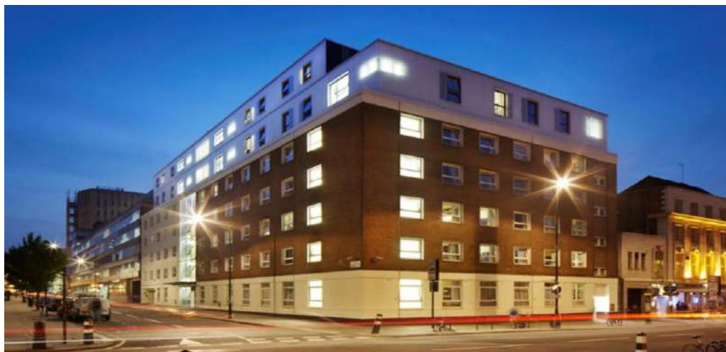
Рис. 25.1 Реконструкция здания 50-ых годов с применением блок-модулей для надстройки двух верхних этажей. Лондон, Англия
