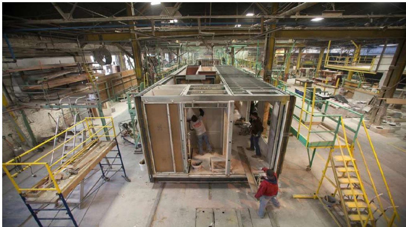
Рис. 24.4 Сборка блок-модуля из легких конструкций
