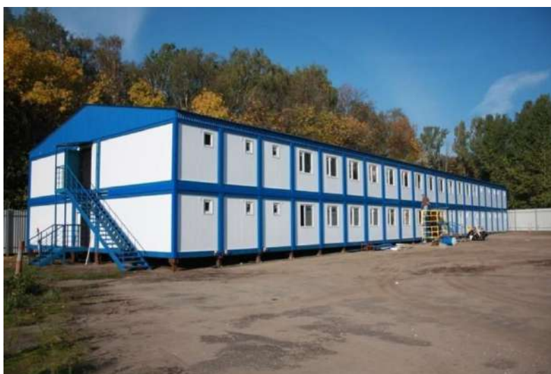
Рис. 24.3 Здание вахтового поселка из блок-контейнеров. Россия
