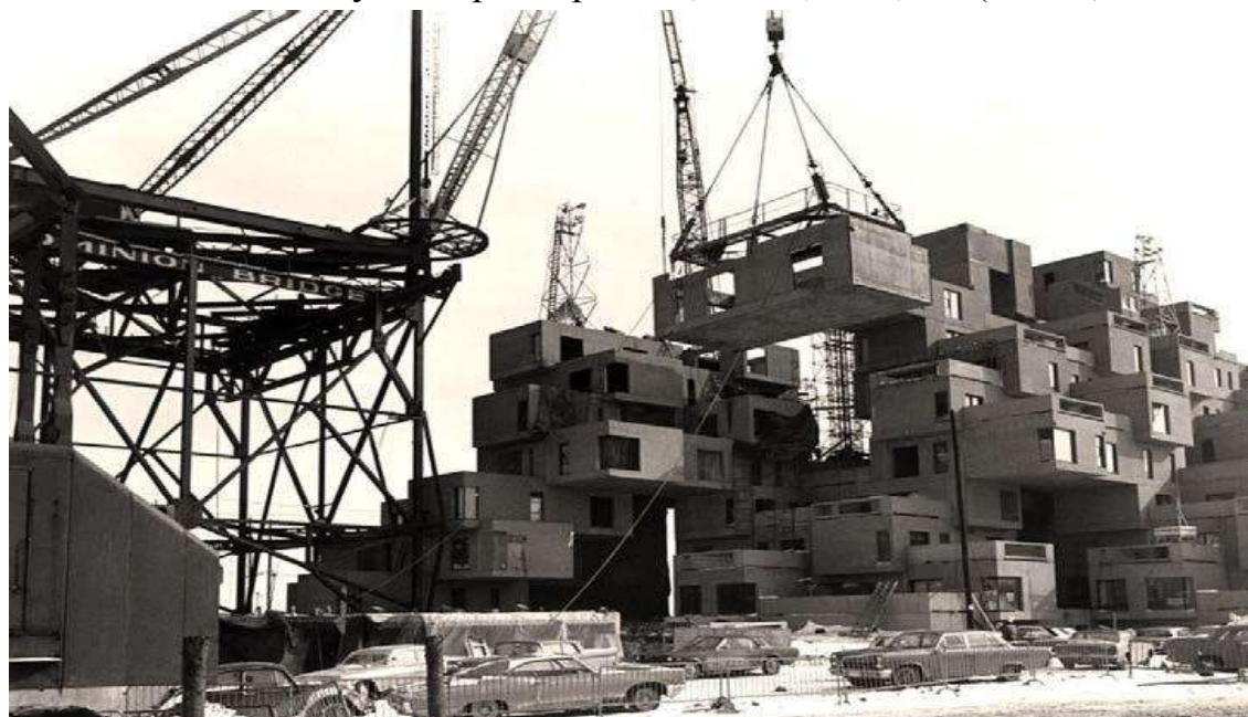
Рис. 23.3 Сборка жилого комплекса «Хабитат 67»
