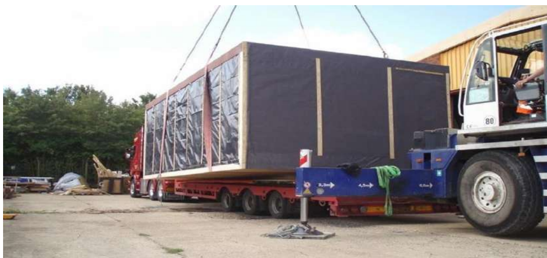
Рис. 24.8 Погрузка превышающего габариты транспортировки блок-модуля на транспортную платформу .
